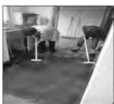
プール始めの清掃
